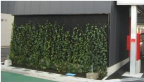
久留米市駅東口立体駐車場
