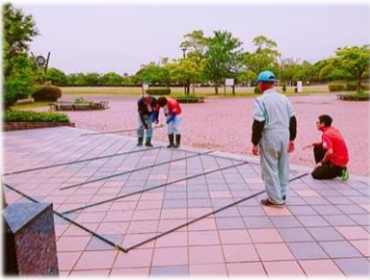
支柱の組み立て
